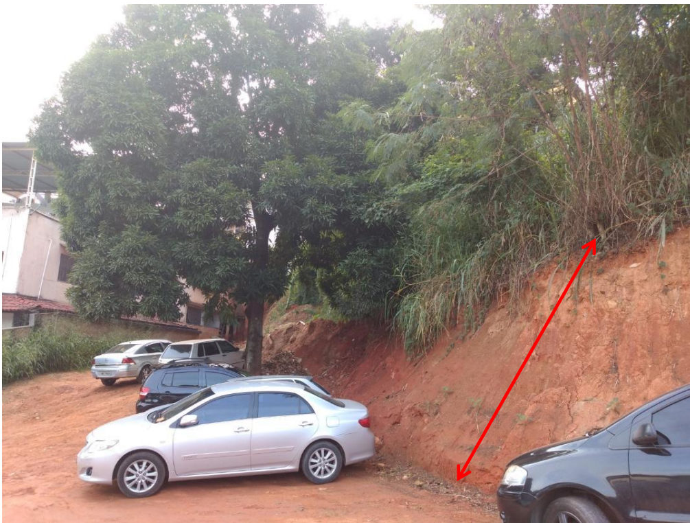
Figura 03 – Aspecto geral da área. No detalhe pode-se visualizar o perfil de solo.
